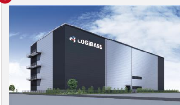
(仮称)上尾市中新井物流センター
